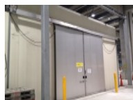
【定温仕分け室(沖縄・香港)】 着工済み
