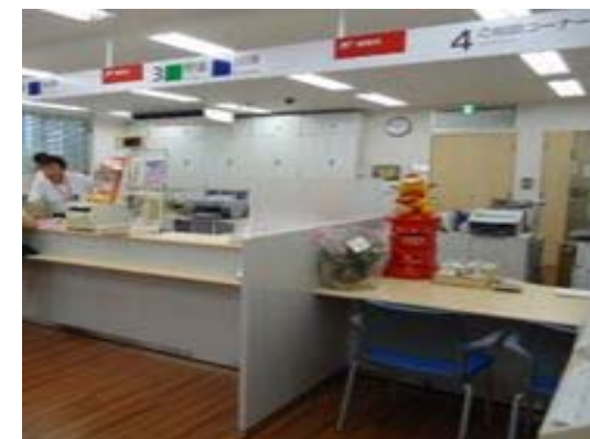
ローカウンターの設置 〔大阪東生野郵便局（大阪府）〕
