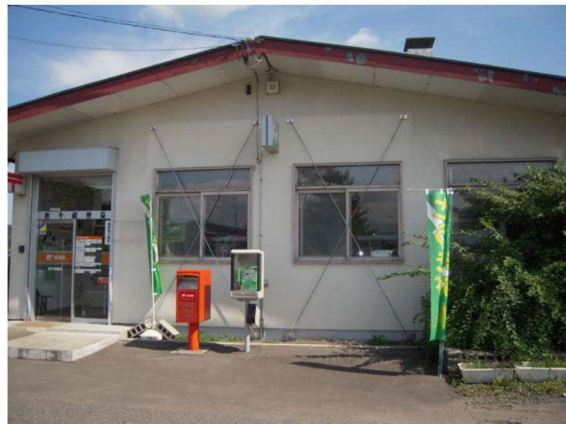
補強後の外観の例
