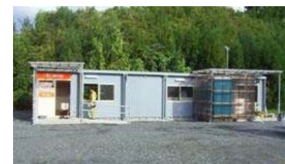
釜石平田郵便局の仮設局舎
