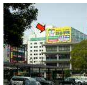
郵便局舎の壁面・ガラス面・ 懸垂幕施設等を利用
