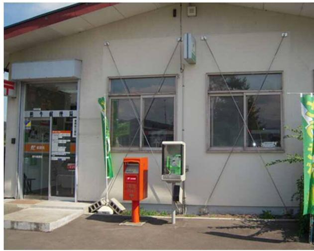
耐震補強工事(金属ブレース設置)の例
